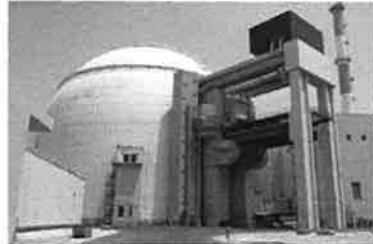
La centrale nucléaire de Boudsahar, en Iran, a été mise en service en septembre 2011. (credit: D R)
